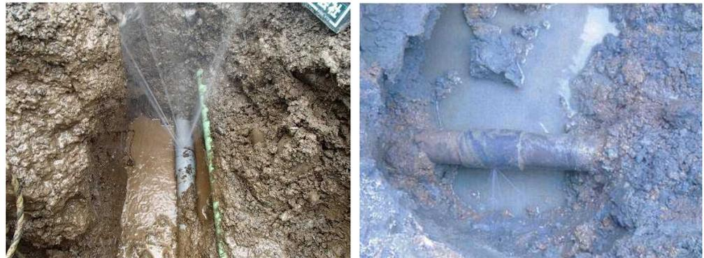
水道管(配水管)の継手部(ジョイント)より漏水している状況
