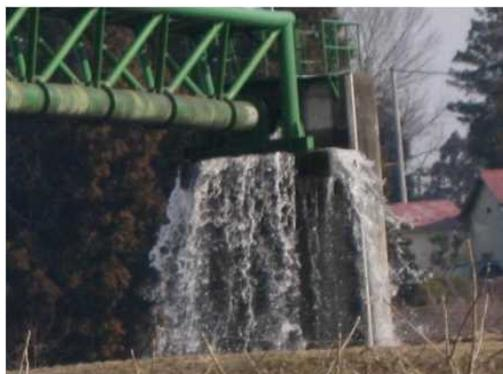
東日本大震災による水管橋の破損
