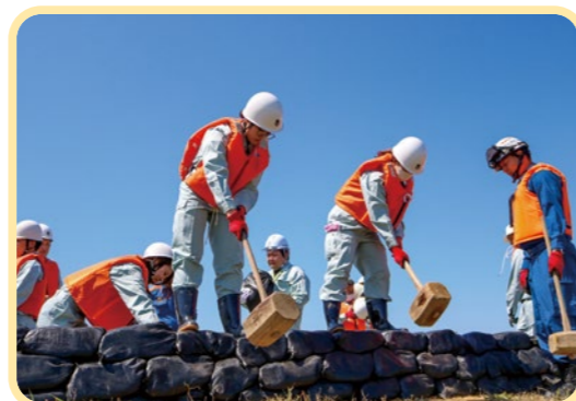
▲積んだ土のうを固める職員
