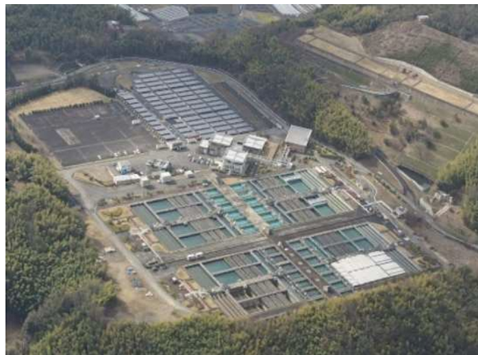
写真 2.1 新山科浄水場 (出典：京都市上下水道局 HP)
