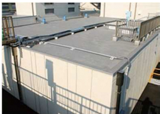
写真 2.2 佐古浄水場配水池
