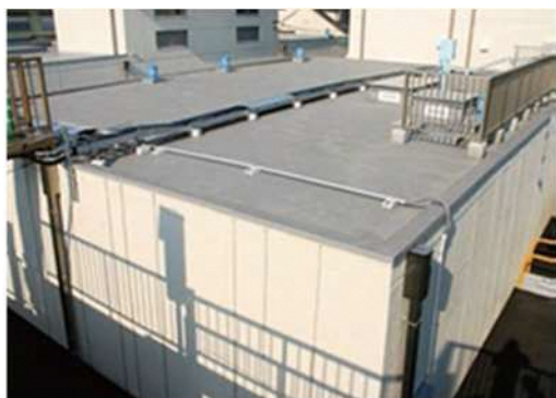
写真 2.2 佐古浄水場配水池
