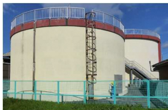
写真 2.3 場外施設配水池
