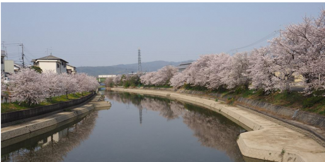
写真 2.2 巨椋池排水幹線
