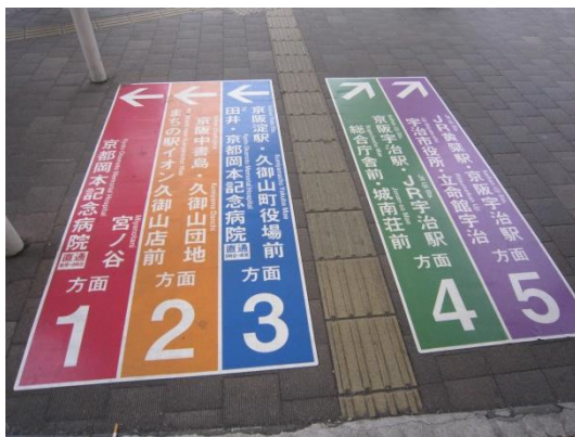
写真 路面標示の設置事例 (近鉄大久保駅)
