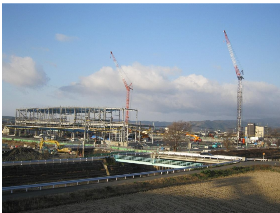
写真 新たな企業進出に向けて造成工事が進む東一口モタレ地区
